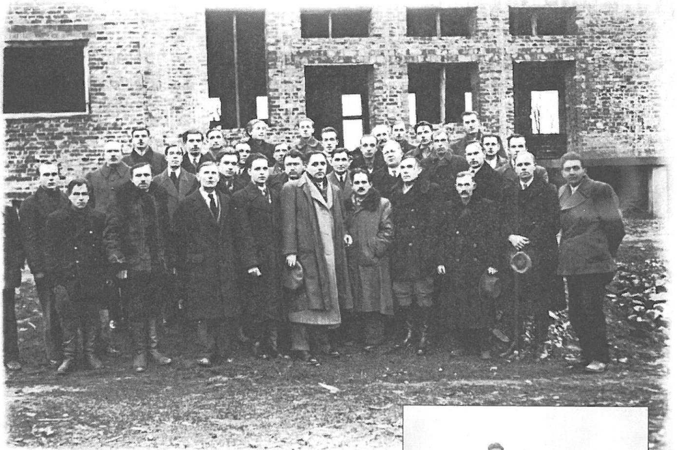
Zdjęcie przedstawiające budynek mleczarni, jakim Niemcy pozostawili go w 1944 r., oraz pierwsi pracownicy i organizatorzy zakładu. (Trzeci z prawej [pierwszy rząd] - mistrz budowlany Wincenty Korniak). Fot. datowana na 1945-46 rok.
