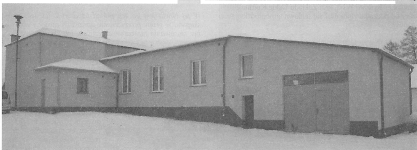
Nowa elewacja i docieplenie budynku remizy OSP w Różańcu Drugim
